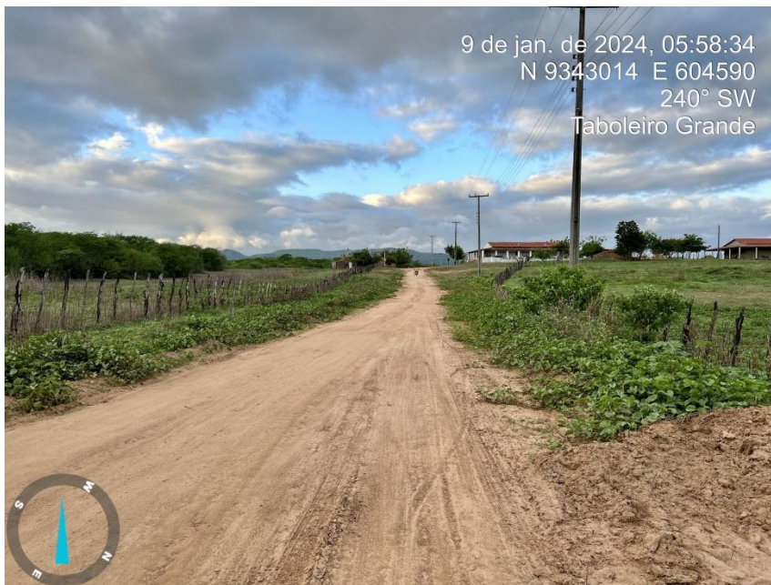
FOTO 03: VIA A SER PAVIMENTADA.
