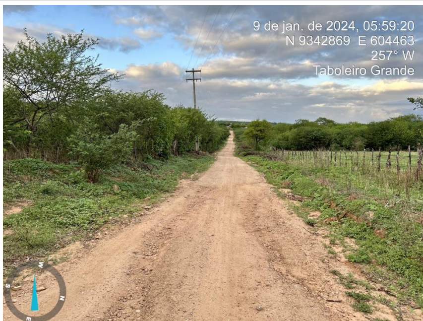
FOTO 04: VIA A SER PAVIMENTADA.
