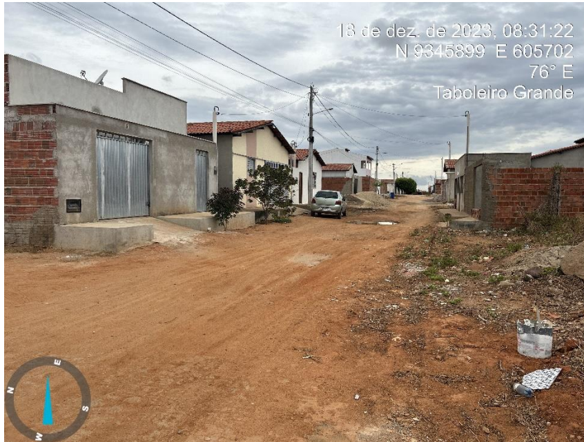
FOTO 03: TRECHO DA RUA FILEMON DE FREITAS.
